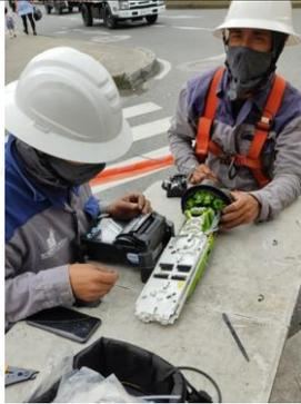
Revisión y reparación de muflas en los diferentes nodos que componen la red de fibra óptica del Municipio
